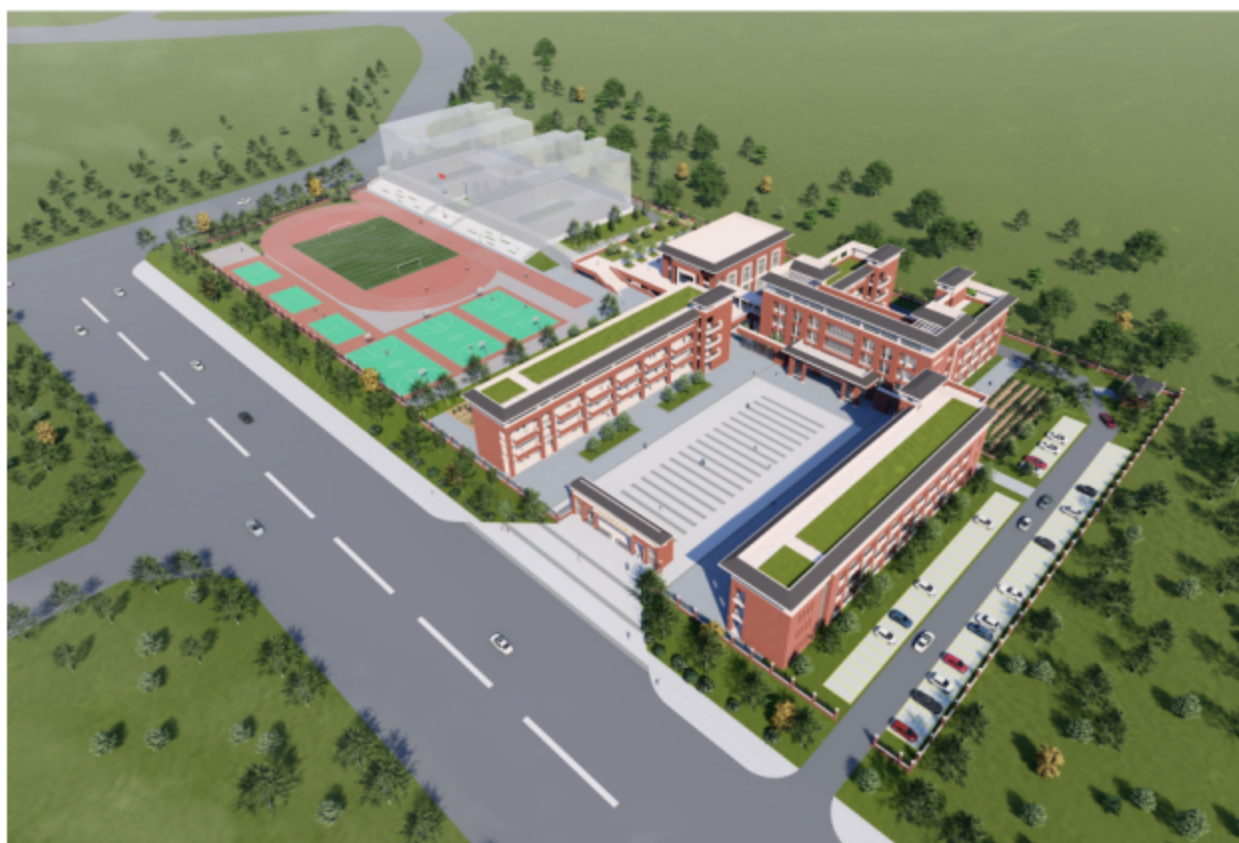
阳西县育才小学建设项目
